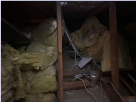
다락방의 단열재가 제자리를 벗어났습니다. 전문 시공업체에 의뢰하여 단열재를 재배치하는 것을 권장합니다.
