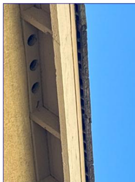
The Soffit Vent
